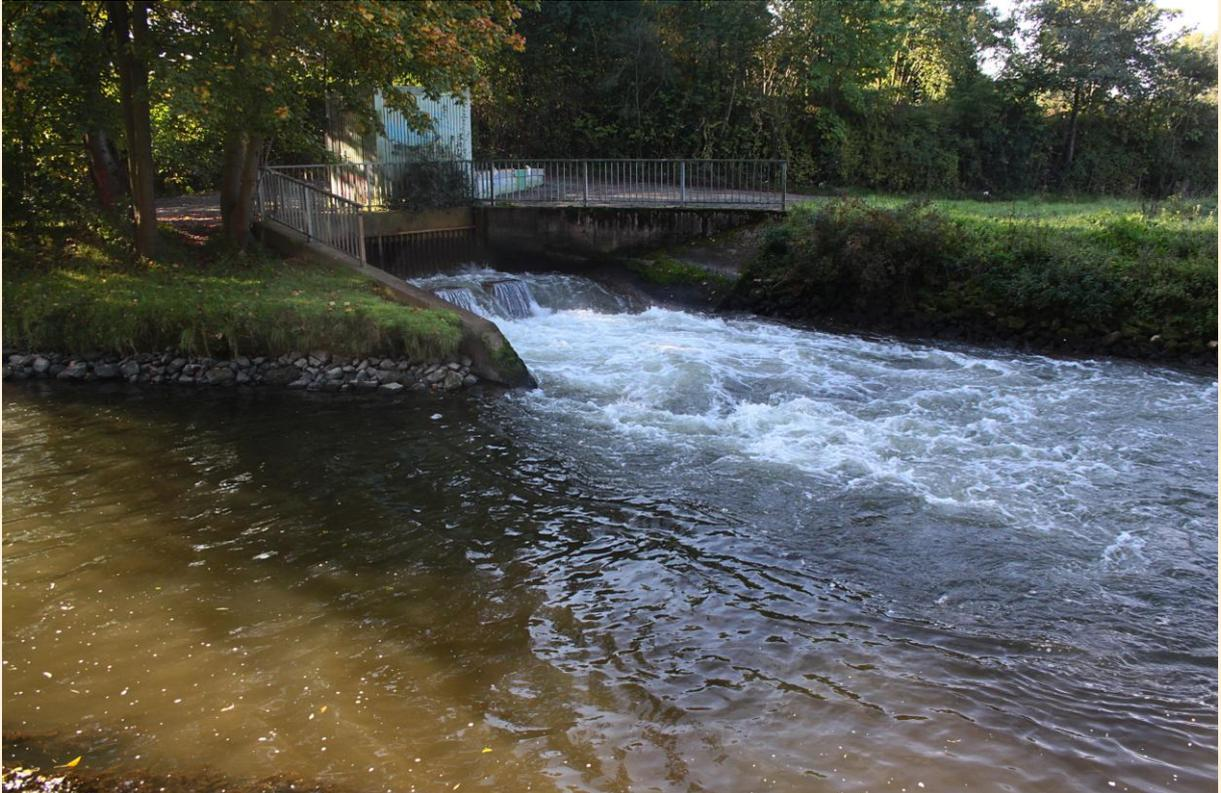
**Abb. 049:** Die Einleitung von Sumpfungswasser (rechts oben im Bild) unmittelbar vor der Einmündung in die neue Erftschleife.
